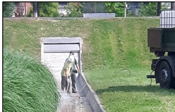
A fine maggio, all'interno del Parco Verga, sono iniziati, a cura di EuroMilano, i lavori di pulitura dei canali dei tre corsi d'acqua artificiali. Tale intervento, programmato da tempo, si era reso necessario per evitare che il distacco del rivestimento del fondale e delle pareti dei canali potesse creare problemi di intasamento dei filtri del sistema di ricircolo e pompaggio dell'acqua.
