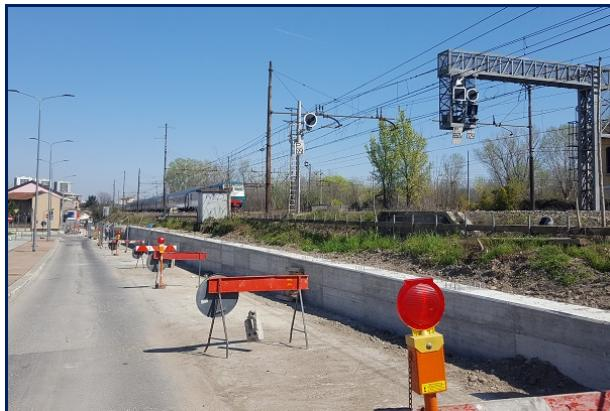
Proseguono i lavori per la realizzazione di una barriera fonoassorbente in via Porretta, lungo il terrapieno della massicciata ferroviaria. Tale barriera risulta già installata nel tratto dove la ferrovia costeggia il Parco Verga e si nota per sua imponenza: ha un'altezza di sette metri circa. All'interno del Quartiere ha preso forma il desiderio comune di ricoprire tale "muro" con della vegetazione e delle piante. In merito sono state già state formulate delle richieste a chi di competenza.
