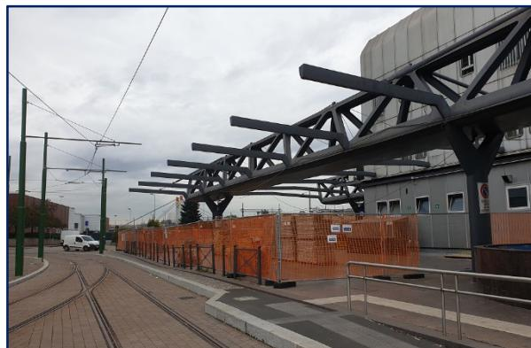
Agli inizi di settembre sono stati avviati i lavori per la realizzazione di una nuova tettoia della stazione ferroviaria di Milano Certosa. Dovrebbero in tal modo terminare i fastidiosi problemi connessi allo stillicidio dell’acqua sui viaggiatori in attesa sulle banchine.
